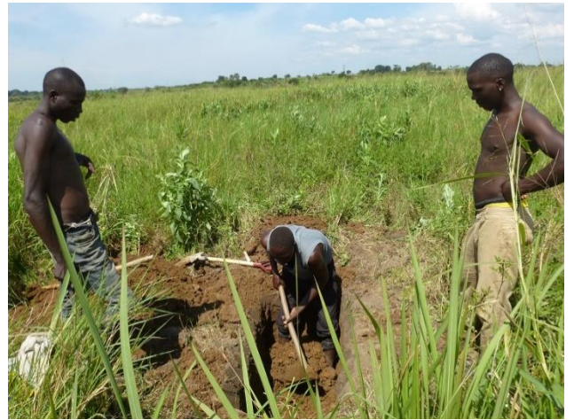
Bau einer Toilette
